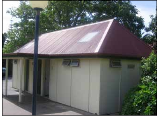
Place de la Poste toilet block (image courtesy of Suky Thompson)
