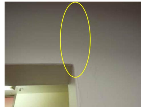
3.24 | DIAGONAL HAIRLINE CRACK IN SHEAR WALL FROM CORNER OF DOORWAY AT GRID 10
