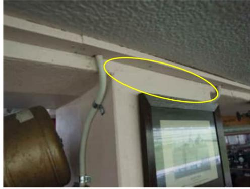
2.25 | CRACK IN BEAM COLUMN JOINT AT GRID 16
