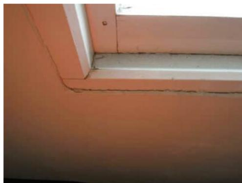
**3.34** | SEPARATION OF GIB FROM WINDOW FRAME BETWEEN GRID 15 AND 16. GRID 14 TO 15 SIMILAR. THESE WINDOW FRAMES DIFFER FROM OTHERS ALONG THIS WALL
