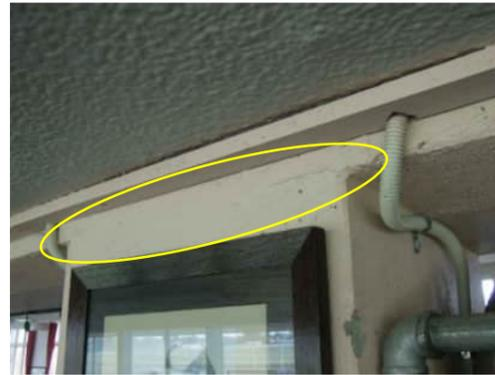
2.26 | CRACK IN BEAM COLUMN JOINT AT GRID 16
