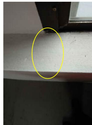
2.35 | HAIRLINE CRACK BELOW WINDOW IN LIFT SHAFT WALL ON GRID 11
