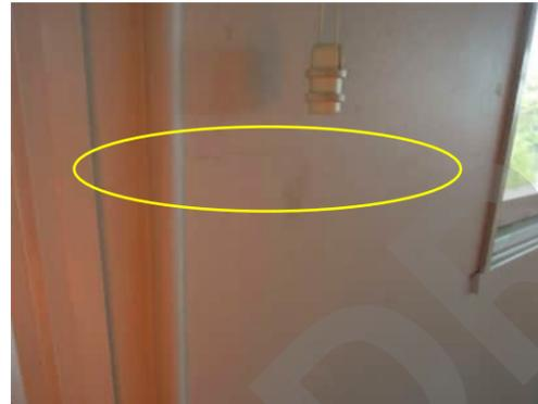
**3.30** | HORIZONTAL HAIRLINE CRACK ALONG GRID 4 COLUMN AROUND 300MM ABOVE BOTTOM OF WINDOW (GRIDS 1-9 AND GRIDS 14-19 SIMILAR)
