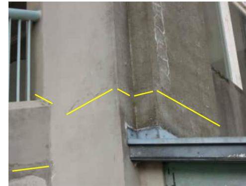
**EW20** | HORIZONTAL CRACK AROUND GRID E COLUMN
