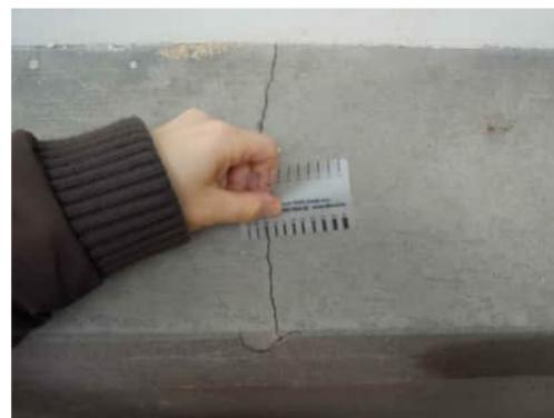
**EW10** | 1.0MM VERTICAL CRACK BELOW WINDOW
