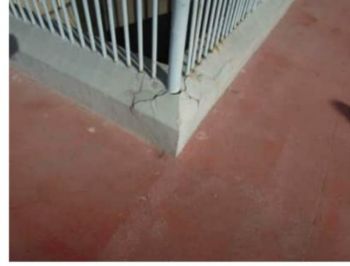
**EXT.2** | DAMAGE TO TOP OF RETAINING WALL AROUND CAST-IN HANDRAIL
