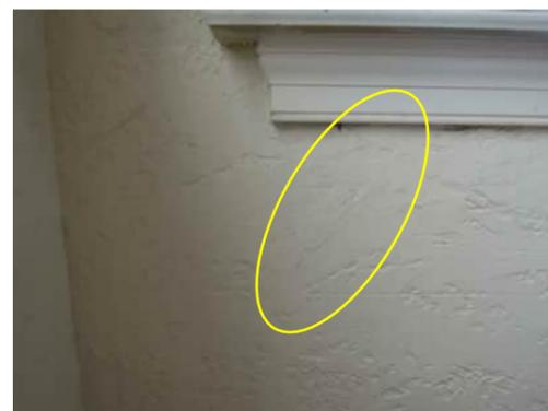
2.10 | 0.1MM DIAGONAL CRACK FROM BOTTOM OF WINDOW AT GRID D
