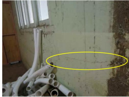
0.13 HORIZONTAL CRACK IN WALL BETWEEN GRID B AND C
