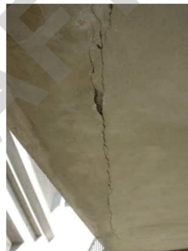
**S17** | CRACK ON UNDERSIDE OF STAIRS UP TO 4MM WIDE WITH LOCALISED SPALLING TO RENDER
