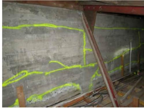
**3.49** MULTIPLE CRACKS TO SHEAR WALL. UPPER CRACK IS THROUGH POUR LINE. VERTICAL CRACK UNDER TRUSS IS 1.2MM WIDE. POOR QUALITY CONCRETE IN BEAM AT BOTTOM. MIDDLE HORIZONTAL CRACK IS 1.8 TO 2MM WIDE
