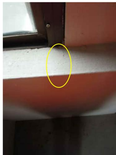
2.34 | HAIRLINE CRACK BELOW WINDOW IN LIFT SHAFT WALL ON GRID 10
