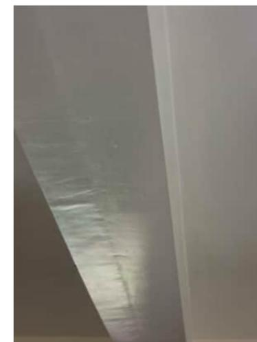
2.36 | TYPICAL CRACKS ALONG LENGTH OF BEAM
