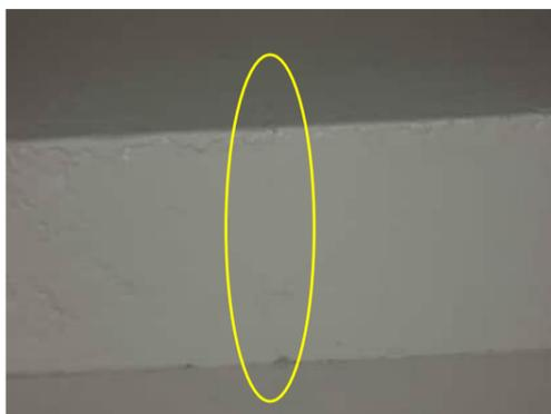
**0.56** CRACK TO BEAM BETWEEN GRID 12 AND 13
