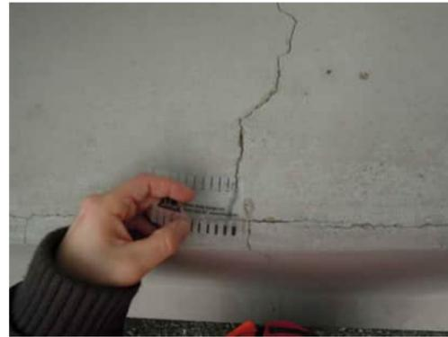
**EW2** | 1.0MM VERTICAL CRACK BELOW GROUND FLOOR WINDOW
