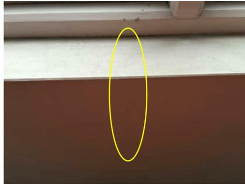
1.29 | HAIRLINE VERTICAL CRACK BELOW WINDOW BETWEEN GRID 12 AND 13
