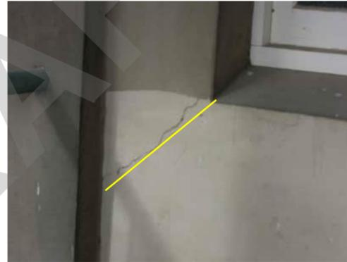
**EW7** | DIAGONAL CRACK BELOW WINDOW ON COLUMN BETWEEN AND GRID C
