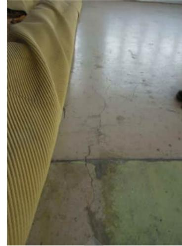
3.3 | CRACK ALONG GRID 2 UP TO 1.8MM WIDE
