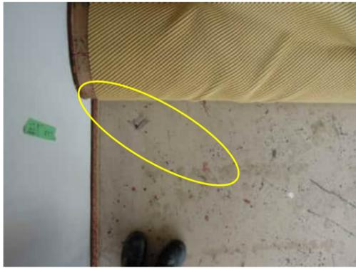
3.13 | CRACK ALONG GRID 20 UP TO 0.9MM WIDE
