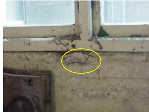
**0.50** SIGNIFICANT CRACK BELOW WINDOW BETWEEN GRID 8 AND 9
