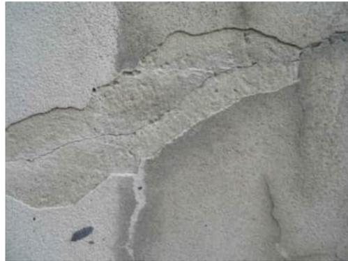
**EE17** | 0.2MM CRACK IN GRID C COLUMN
