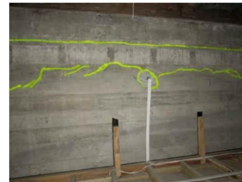
3.48 | HORIZONTAL CRACKS TO SHEAR WALL. UPPER CRACK IS THROUGH POUR LINE. LOWER CRACK IS 0.2 TO 0.5MM WIDE
