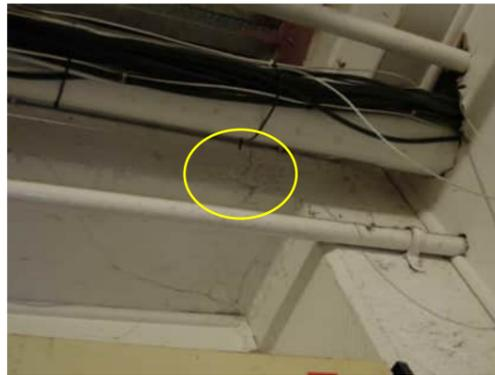
**0.37** SIGNIFICANT CRACK TO BEAM NEAR BEAM COLUMN JOINT ON GRID 9
