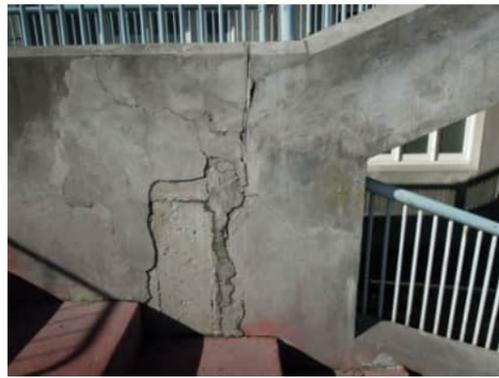
**S11** | SIGNIFICANT CRACKS ON THE SIDE OF THE STAIRS UP TO 3.5MM WITH RENDER SPALLING OFF
