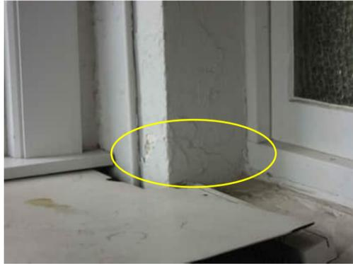
1.13 | CRACK FROM BOTTOM CORNER OF WINDOW IN WALL BETWEEN GRID B AND C
