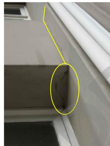
**EW6** | TYPICAL SEPARATION BETWEEN WALLS AND COLUMNS
