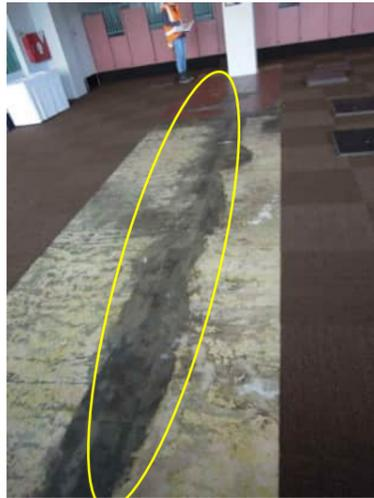
3.5 | CRACK ABOVE GRID 6 BEAM WHICH HAS BEEN PARTIALLY REPAIRED
