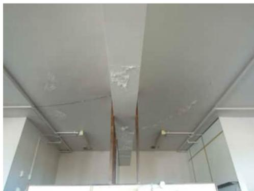
3.46 | MOISTURE DAMAGE TO CEILING AND BEAM ON GRID 11
