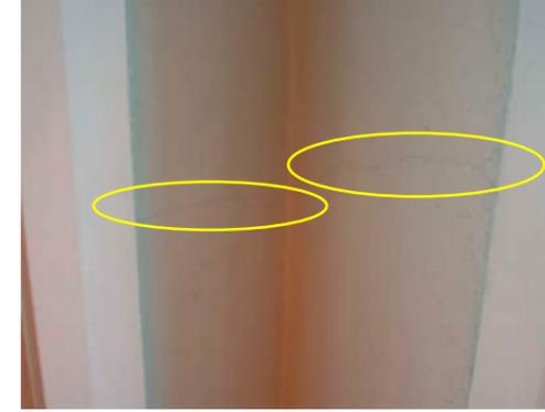
3.20 | HAIRLINE CRACK AROUND 300MM ABOVE BOTTOM WINDOW IN GRID E COLUMN
