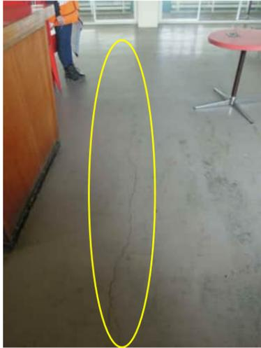
2.1 | TYPICAL CRACK ABOVE BEAM ON GRID 7, UP TO 1.6MM
