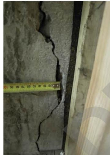
**3.54** FULL HEIGHT VERTICAL CRACK UP TO 15MM WIDE
