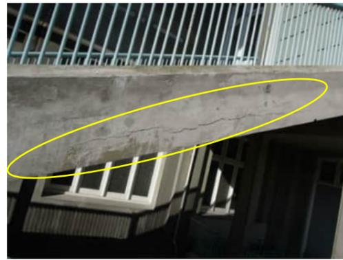
**S12** | CRACK UP TO 4MM ALONG THE STRINGER
