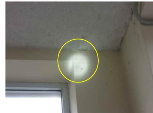
0.20 CRACK ABOVE DOOR FRAME AT GRID D
