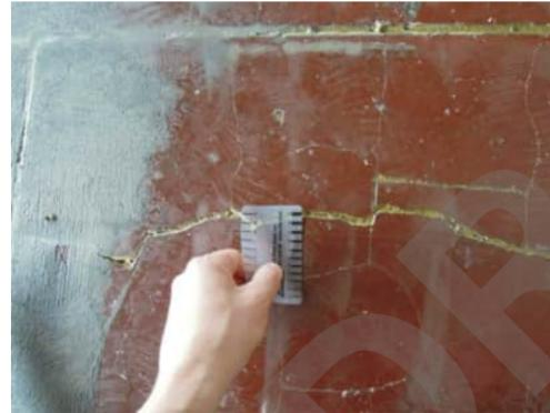
3.6 | CRACK ABOVE GRID 6 BEAM IS UP TO 5MM WIDE
