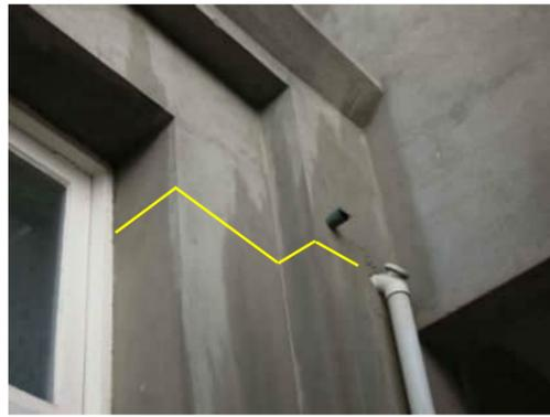
**EW13** | HORIZONTAL CRACK NEAR CEILING LEVEL OF GROUND FLOOR, ON COLUMN BETWEEN GRID B AND GRID C
