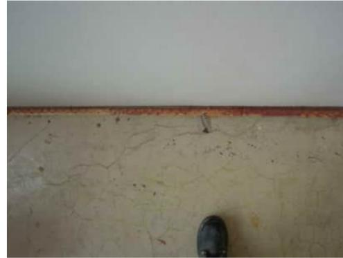
3.2 | CRACK UP TO 0.8MM ALONG GRID 1
