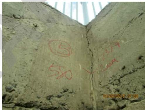
**RW.7** CRACK IN CORNER OF RETAINING WALL, 2MM WIDE
