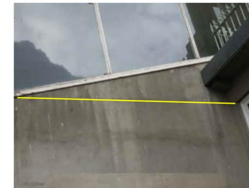
**EW12** | HORIZONTAL CRACK IN CONCRETE WALL OF LOWER STAND
