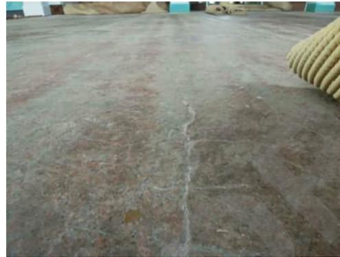
1.6 TYPICAL CRACK OVER THE CENTRE OF BEAMS RUNNING BETWEEN GRID C AND GRID D
