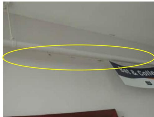
2.12 | SEPARATION BETWEEN WALL AND BEAM BETWEEN GRID C AND GRID D
