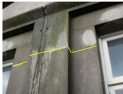
**EW14** | HORIZONTAL CRACK NEAR CEILING LEVEL OF GROUND FLOOR ON COLUMN AT GRID B
