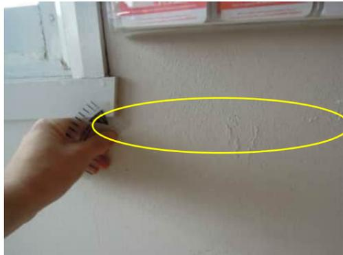
**3.29** | HORIZONTAL HAIRLINE CRACK ALONG GRID 20 COLUMN AT BOTTOM OF WINDOW (GRID 1, 2, 3 AND 21 SIMILAR)
