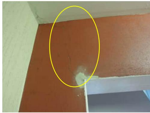
**3.25** | 0.8MM DIAGONAL CRACK ON BACK OF SHEAR WALL FROM CORNER OF DOORWAY AT GRID 10
