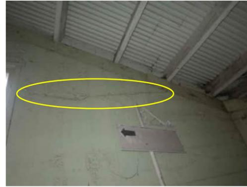
0.15 HORIZONTAL CRACK TO TOP OF WALL AT GRID A
