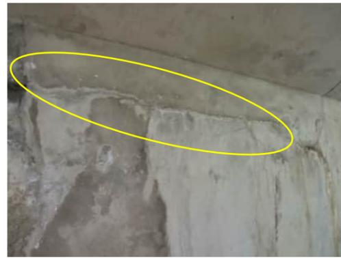
**S13** | HORIZONTAL CRACK UP TO 0.5MM ON WALL BELOW STAIRS
