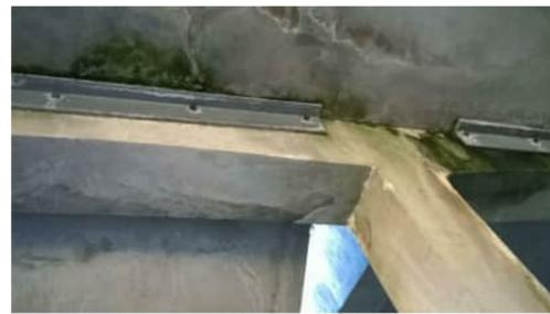
**R26** | CRACK BETWEEN SLAB AND BEAM UNDER LANDING SLAB. STEEL ANGLES HAVE BEEN FITTED TO SUPPORT SLAB
