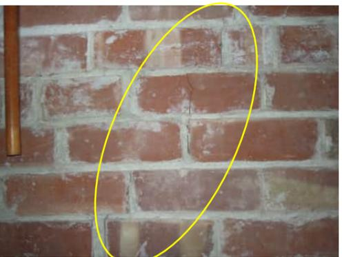
**0.68** DIAGONAL STEP CRACKING IN RED BRICK INFILL PANEL
