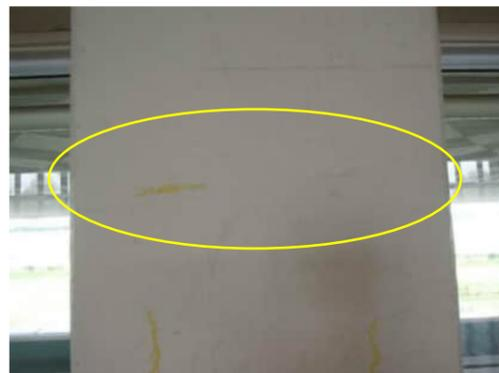
2.21 | HAIRLINE CRACK AROUND GRID 6 COLUMN
