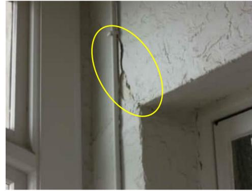
1.12 DIAGONAL CRACK FROM TOP CORNER OF WINDOW IN WALL BETWEEN GRID B AND C
