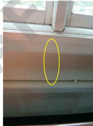
2.31 | 0.1-0.2mm WIDE VERTICAL CRACK BELOW WINDOW BETWEEN GRID 16 AND 17
