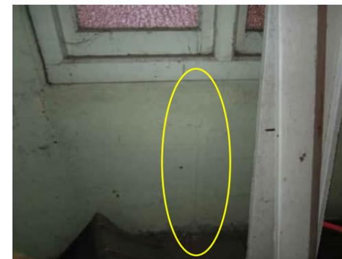
0.23 0.2mm VERTICAL CRACK BELOW WINDOW BETWEEN GRID 2 AND 3
