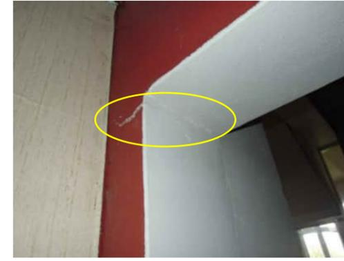
**3.28** | HORIZONTAL CRACK AROUND SIDE AND BACK OF GRID 13 COLUMN
