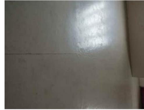
2.4 | CRACK ABOVE BEAM AT CONSTRUCTION JOINT UP TO 2.5MM
