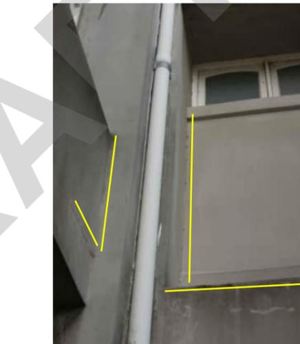
**EW19** | SEPARATION BETWEEN GRID D COLUMN AND INFILL WALL
