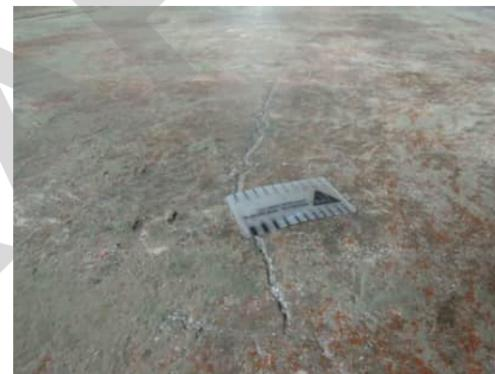
1.7 CRACKS ARE UP TO 5MM ON THE SURFACE
