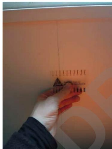
**0.53** TYPICAL SEPARATION BETWEEN PLASTER BOARD PANELS, OCCURS FROM GRID 13 TO GRID 20
