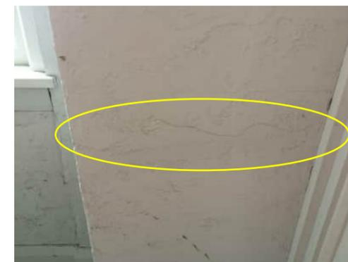
1.24 | HORIZONTAL CRACK AROUND GRID C COLUMN 1m FROM FLOOR
