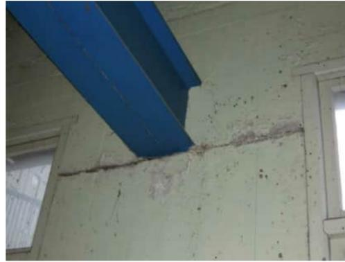
0.14 HORIZONTAL CRACK AT TOP OF WALL AT GRID B IN CONSTRUCTION JOINT, BELOW CAST-IN STEEL BEAM.
