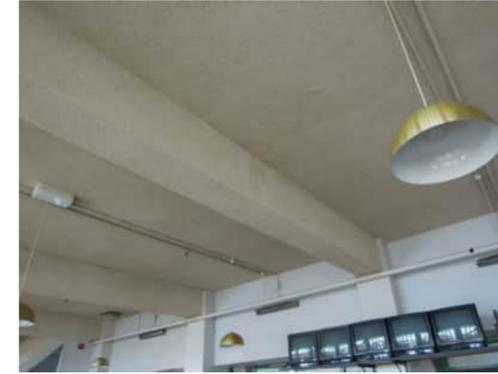
3.44 | MOISTURE DAMAGE TO BEAM AND CEILING AT GRID 7
