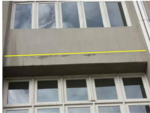
**EW1** | SIGNIFICANT CRACK ABOVE FIRST FLOOR WINDOW BETWEEN GRID C AND GRID D
