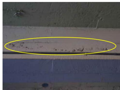
**0.58** POORLY COMPACTED CONCRETE ALONG BEAM AT GRID 6 (GRID 8 SIMILAR)
