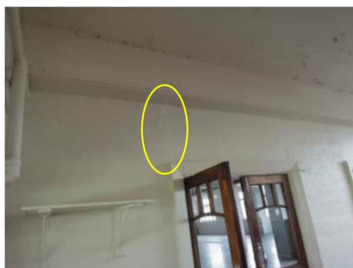
2.11 | CRACKS ABOVE DOOR FRAME IN WALL ALONG GRID 8 BETWEEN GRID C AND GRID D
