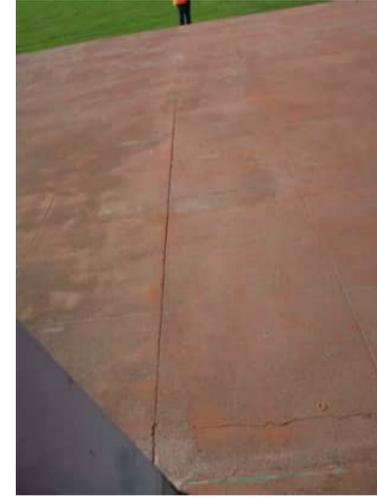
**EXT.7** | TYPICAL CRACK IN JOINT
