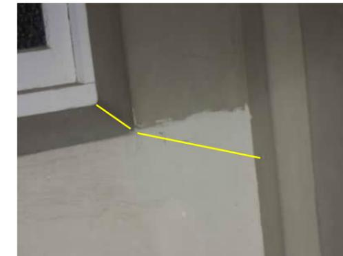
**EW8** | DIAGONAL CRACK BELOW WINDOW ON COLUMN BETWEEN GRID B AND GRID C
