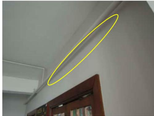
2.17 | SEPARATION BETWEEN WALL AND BEAM BETWEEN
