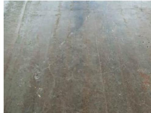
1.8 CRAZED CRACK PATTERN ON SLAB BETWEEN GRID 4 AND 5
