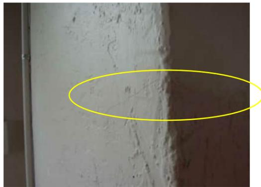
1.10 HAIRLINE HORIZONTAL CRACK AROUND COLUMN AT MID HEIGHT
