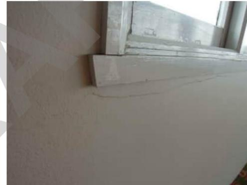
**3.31** | HORIZONTAL CRACK IN WALL BELOW WINDOW BETWEEN GRID 2 AND GRID 3
