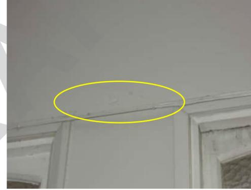
2.19 | CRACK BETWEEN WINDOWS BETWEEN GRID D AND
