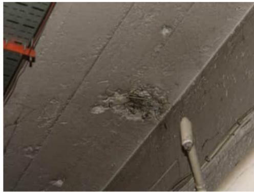
**0.60** VOID ON CEILING EXPOSING THE REINFORCING AT GRID 10
