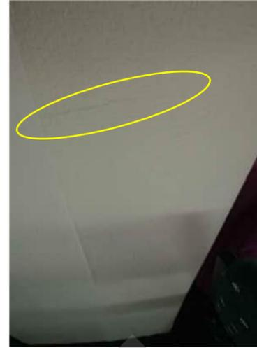
2.27 | MULTIPLE HAIRLINE HORIZONTAL CRACKS DOWN SIDE OF COLUMN ON GRID 16 (GRID 17 SIMILAR)
