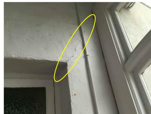
1.23 | DIAGONAL CRACK FROM TOP CORNER OF WINDOW IN WALL BETWEEN GRID B AND C
