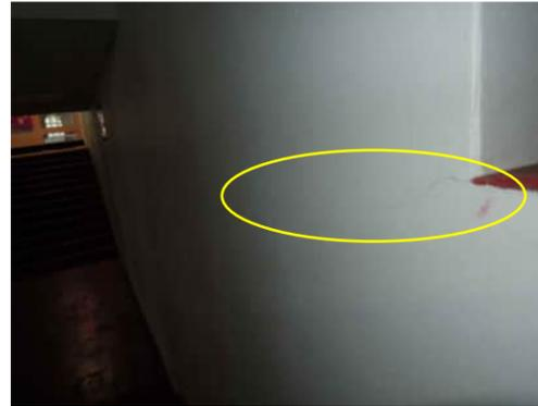
**3.26** | HORIZONTAL HAIRLINE CRACK ALONG SHEAR WALL FROM GRID 10 TO GRID 12
