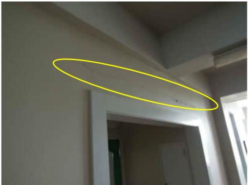
1.17 | HORIZONTAL CRACK ALONG WALL BELOW THE BEAM ABOVE OPENING
