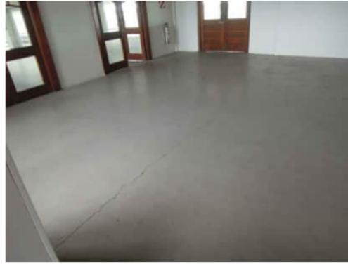
2.2 | CRACK ABOVE BEAM ON GRID 9, UP TO 10MM
