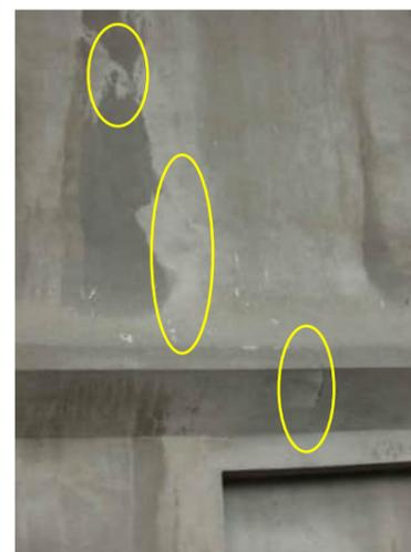
**EW11** | VERTICAL CRACK ABOVE GROUND FLOOR WINDOW GRID A AND GRID B
