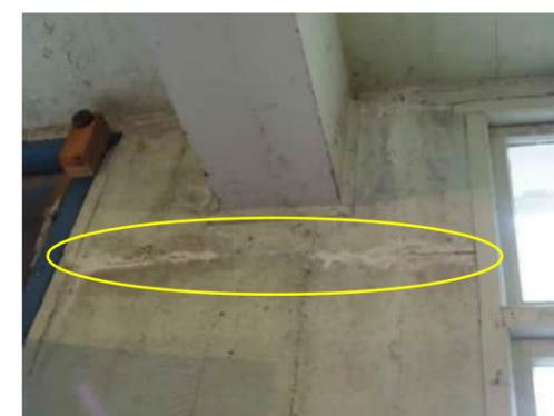
**0.47** CRACK IN CONSTRUCTION JOINT ON GRID 5 COLUMN
