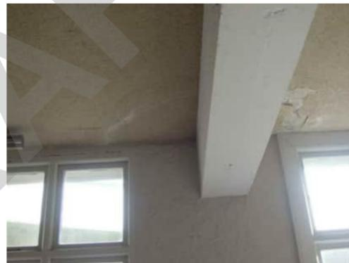
1.31 | TYPICAL MOISTURE DAMAGE TO CEILING AT BEAM COLUMN JOINTS ALONG GRID D
