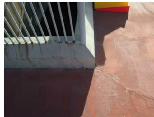
**EXT.10** | CRACK IN SLAB FROM CORNER OF RETAINING WALL
