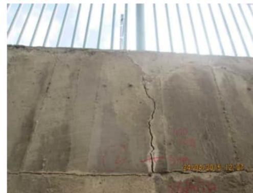
**RW.4** TYPICAL CRACK FROM TOP OF WALL TO JOINT, CRACKS RANGE FROM 0.2MM TO 5MM
